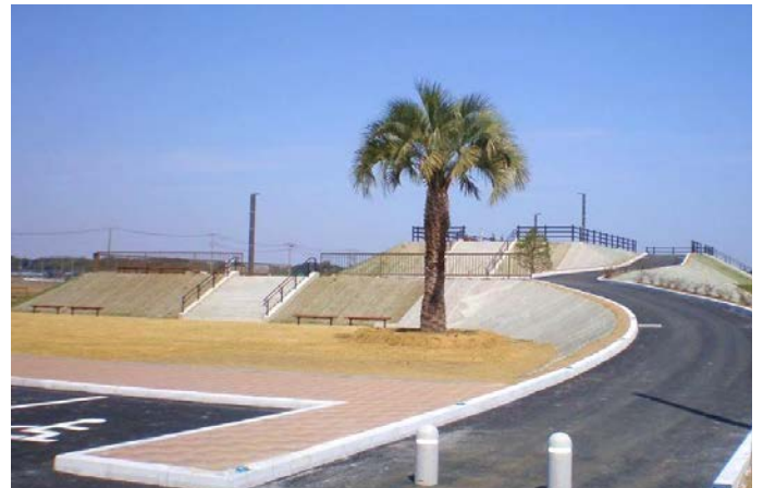
防災公園盛土材
