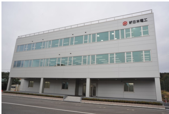
徳島工場 新事務所 建 物：鉄骨3階建、執務人数約70名 特 長：防災機能の整備 働き方改革を促進する執務室空間
