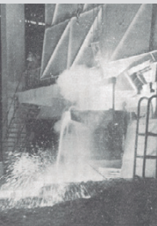
大門工場に設置した低炭素フェロクロム用電気炉
