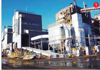
徳島工場1号電気炉生産能力増強工事
