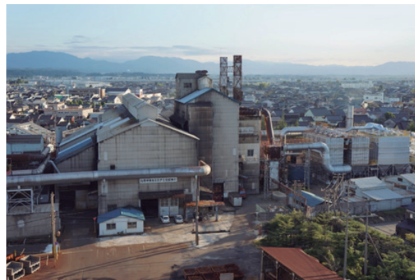
フェロボロン生産設備建屋 (富山工場 [射水地区])
