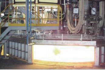
増強した北陸工場のフェロボロン製造設備
