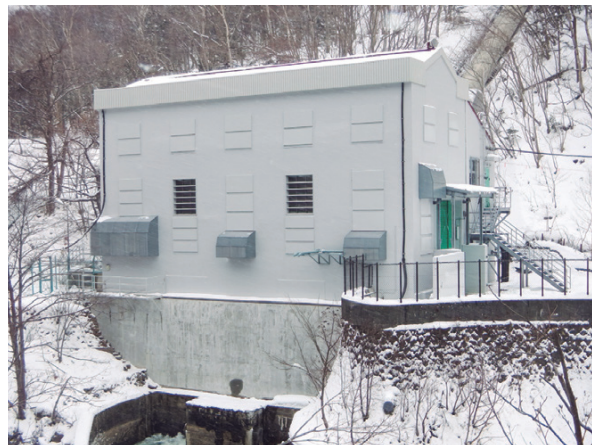
幌満川第3発電所
