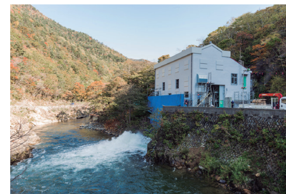
工事中の幌満川第3発電所
