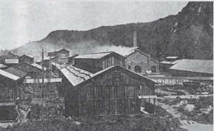
昭和初期の中央電氣田口工場
