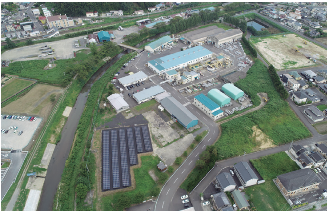
太陽光パネル
