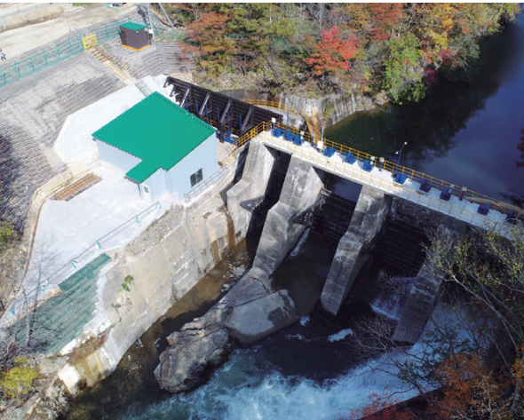
第2発電所堰堤
