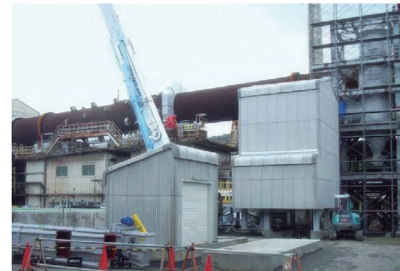
建設中の徳島工場SLP製造用マンガン鉱石の予備還元設備
