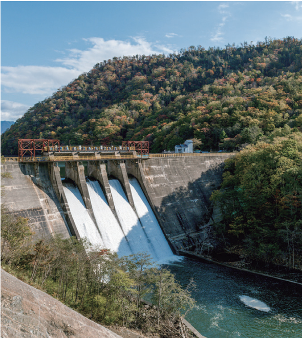
第3発電所ダム
