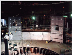
徳島工場1号電気炉能力増強工事
