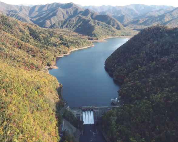
第3発電所ダム
