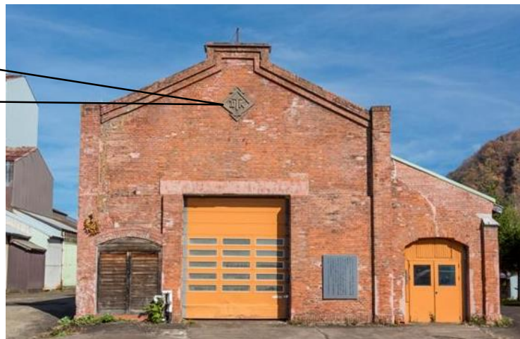
現存する赤煉瓦建屋
