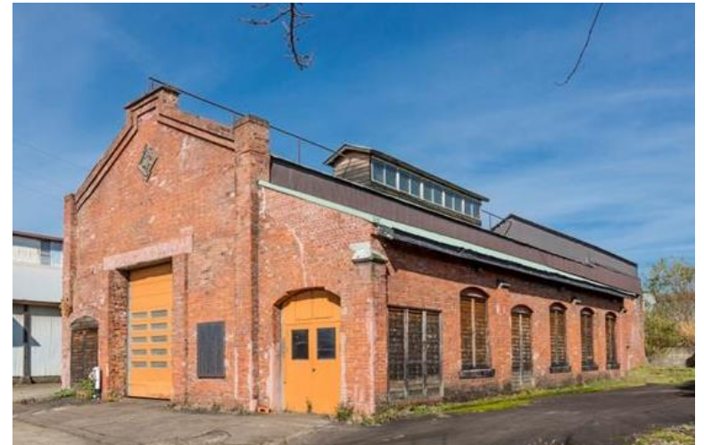
現存する赤煉瓦建屋
