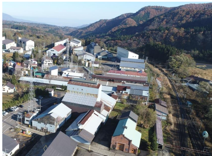
妙高工場全景
